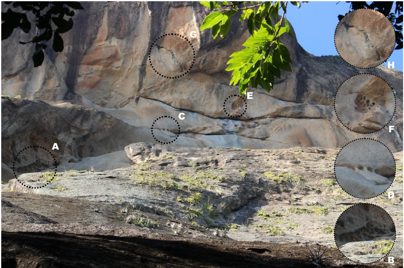
Figura 14. Parede vertical (metade inferior da foto) e a base da fratura de descamação suspensa (metade superior) com a ocorrência de tafoni associados a um sistema de descontinuidades na face norte do morro Pão de Açúcar: registro de estruturas associadas de aglomeração de alvéolos ( honeycombs ) (A-B); ocorrência de alvéolos (pequenas cavidades isoladas, semelhantes àquelas ilustradas na Figura 4A, devido a presença de veio/dique ou arcadas lenticulares (cavidades em sequência) em planos de fratura com disposição subvertical e vertical (C-D); ocorrência de honeycombs sobre uma concavidade na parte inferior da fratura de descamação suspensa (E-F); disposição de veios de pegmatites (G-H). Os escorrimentos de água provenientes da parte superior do morro permitiram a colonização, provavelmente por líquens da parede rochosa protegida de precipitação. A direita do C e abaixo do E foi possível
