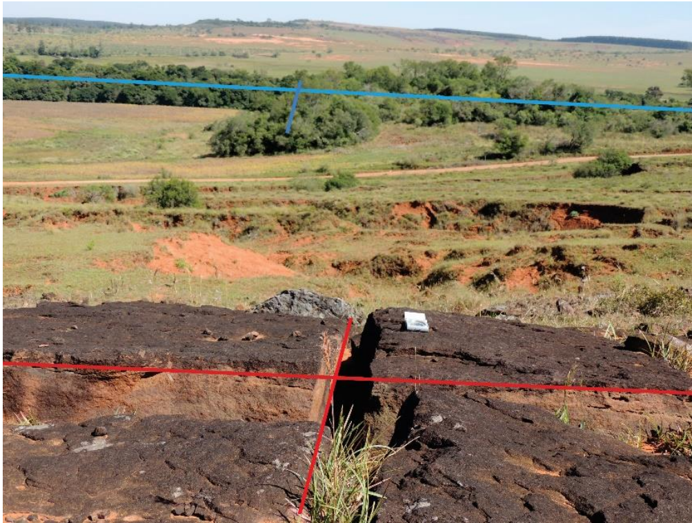
Figura 23. Bloco da Formação Guará, no entorno da Feição Erosiva 6, cujas fraturas ocorrem na direção principal N12°E e secundária N45°W, concordantes com as drenagens delimitadas, ao fundo (linhas azuis). Bacia Hidrográfica do Arroio Miracatu, RS. Fonte: acervo pessoal dos autores (abril de 2018).
