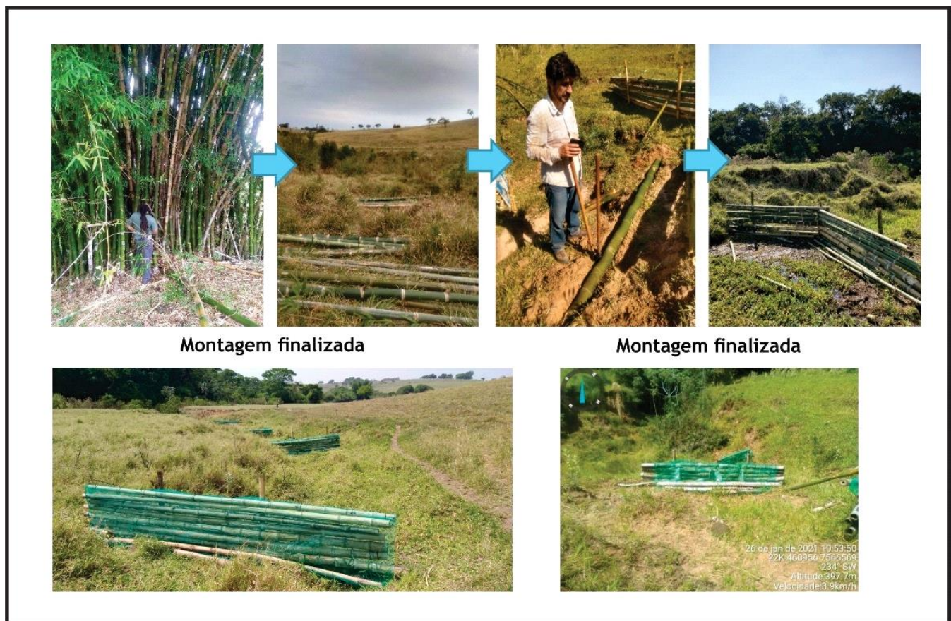
Figura 3. Sequência de montagem das estruturas de bioengenharia (barramentos) com o uso de paliçadas de bambus e mantas de sombrites de polietileno.
