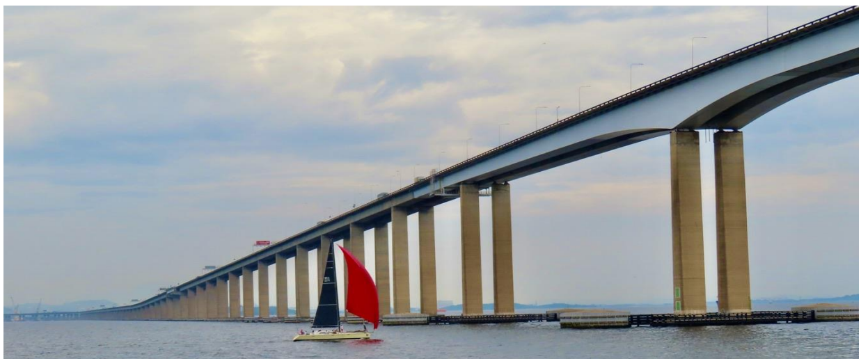
Figura 20. A ponte Rio-Niterói tem dentro da água 70 pilares e 28 estruturas cilíndricas de concreto. No total, esses pilares formam um arquipélago com área de incrustação para as espécies marinhas superior a 40.000 m 2 . Foto do autor.
