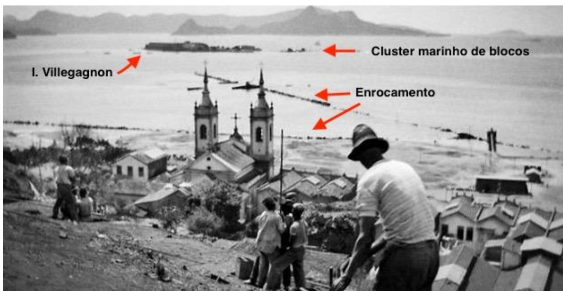
Figura 15. Vista do extinto Morro do Castelo no final da década de 1910, com os enrocamentos para formar o aterro dos anos 1920. A expansão do aterro na década de 1940/50 para construir o Aeroporto Santos Dumont se estendeu até a Ilha de Villegagnon. A ilha era antes um arquipélago com uma pequena baía rochosa, costões, CMB e cluster marinho de blocos, que foram aterrados para a construir a Escola Naval, conforme mostram fotografias da época. Foto: Ermakoff (2009).
