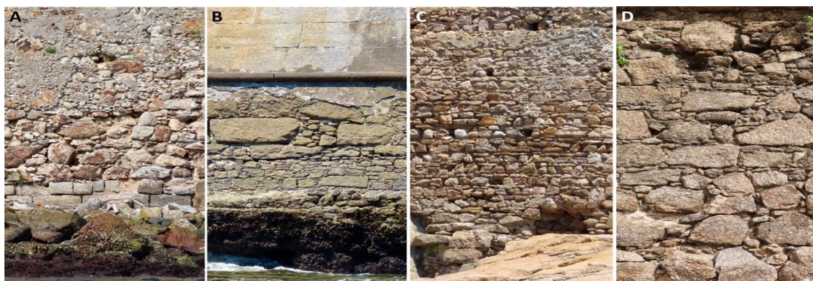
Figura 13. Muros rústicos das fortificações militares na Baía de Guanabara, construídos com calhaus e matações coletados no local. (A) Muro do extinto Forte de São Francisco Xavier, construído em 1733 na Ilha de Villegagnon. (B) Forte da Laje, construído em 1730. A parte superior foi restaurada em 1901. (C) Fortaleza de São João, Reduto de São Teodósio. Essa parte foi construída possivelmente em 1618. (D) Muro da Praia Vermelha construído provavelmente em 1767. As idades das construções foram baseadas em Marenga e Silva (2015) . As escalas das fotos são variadas. Fotos do autor.
