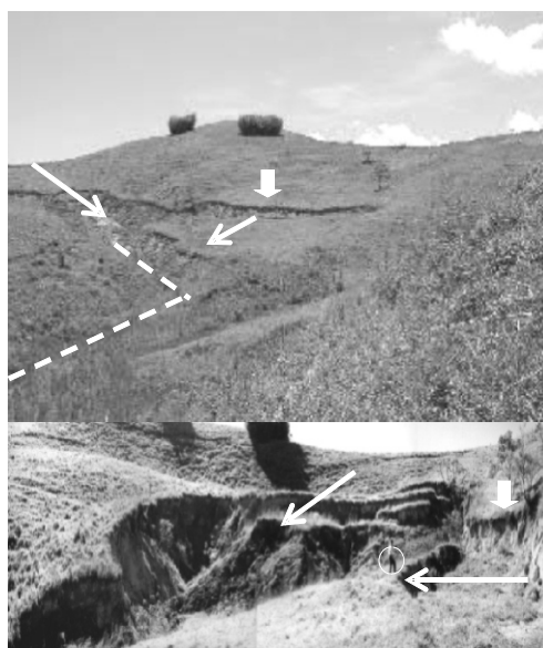
Figura 27. Avanço regressivo do canal-erosivo (voçoroca) na encosta traseira do anfiteatro Três Barras; o descalçamento da encosta pelo voçorocamento propiciou o deslizamento em dois sentidos, como indicam as setas brancas (acima e abaixo); as setas pretas localizam a fenda de tração associada ao movimento do regolito para jusante; o círculo indica uma pessoa para escala.
