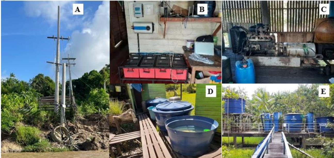
**Figura 17.** Sistema de Distribuição de Energia e Captação de Água. Legenda: (A) Poste Elétrico sendo levado pela Erosão; (B) Sistema de Energia Fotovoltaico; (C) Sistema Elétrico à Diesel; (D) Sistema de Captação da Água da Chuva, Comunidade de Maranata; (E) Estação de Dessalinização, Comunidade do Franquinho. Fonte: dados de campo, 2022.
