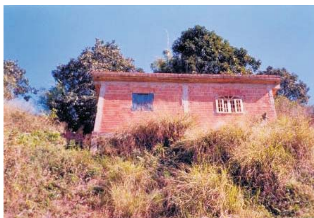
Figura 8 - Necessidade de remoção de casa localizada no topo da cicatriz de deslizamento de terra. Risco iminente de deslizamento da encosta, devido à elevada declividade da mesma (52°). Foto A. J. T. Guerra, 2005.
