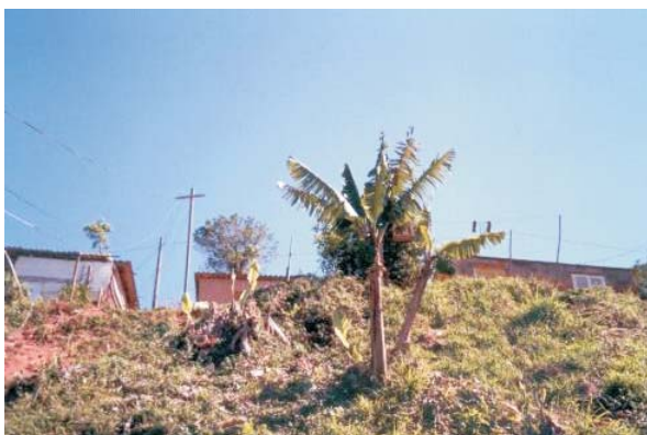
Figura 4 - Três casas sugeridas para remoção devido a sua localização inadequada, próximo à área de convergência de fluxos, e à elevada declividade da encosta (45°). Foto A. J. T. Guerra, 2005.
