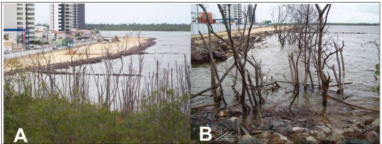
Figura 8 – Fotografias da área de estudo com obra de contenção durante a maré alta, com destaque para a vegetação morta.
